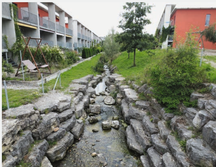
Fig. 3 Des ruisseaux quasi naturels remplacent les ruisseaux canalisés et remplissent de nombreuses fonctions en zone urbaine.
