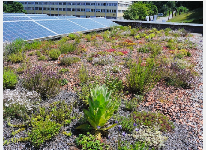
Fig. 2 Les toits et façades végétalisés emmagasinent une grande partie des précipitations, réduisent la température de surface par évapotranspiration et favorisent la diversité des espèces. (©VSA)
