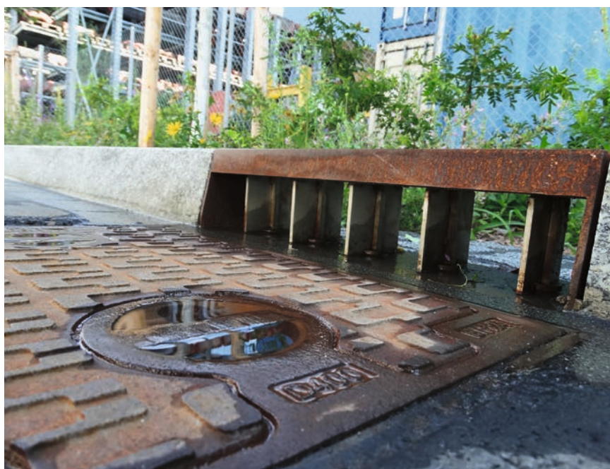
La Giessereistrasse à Zurich: l'eau de pluie ne s'écoule dans la canalisation que pendant les mois d'hiver pendant lesquels du sel est épandu. Le reste du temps, l'eau de pluie est dirigée vers la zone de végétation où elle s'écoule lentement et peut s'évaporer par les arbres (collecteur de boue fermé, bordure ouverte).
